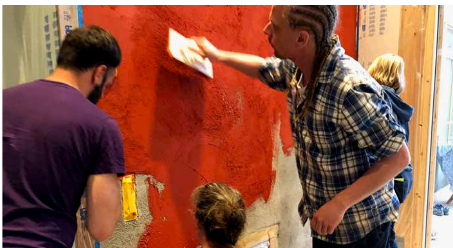
När Lagnö Bo byggdes hjälptes medlemmarna i bygggemenskapen åt att bygga väggar av uppgrävd lera för husbygget, blandat med halm och dynga. Sådana väggar finns på hela bottenvåningen, dvs väggar till 11 lägenheter. Foto: Anita Blom af Ekenstam.
